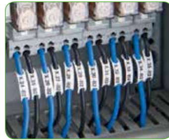
211-161 ve 211-162 içten geçmeli kablo etiket uygulaması etiket
